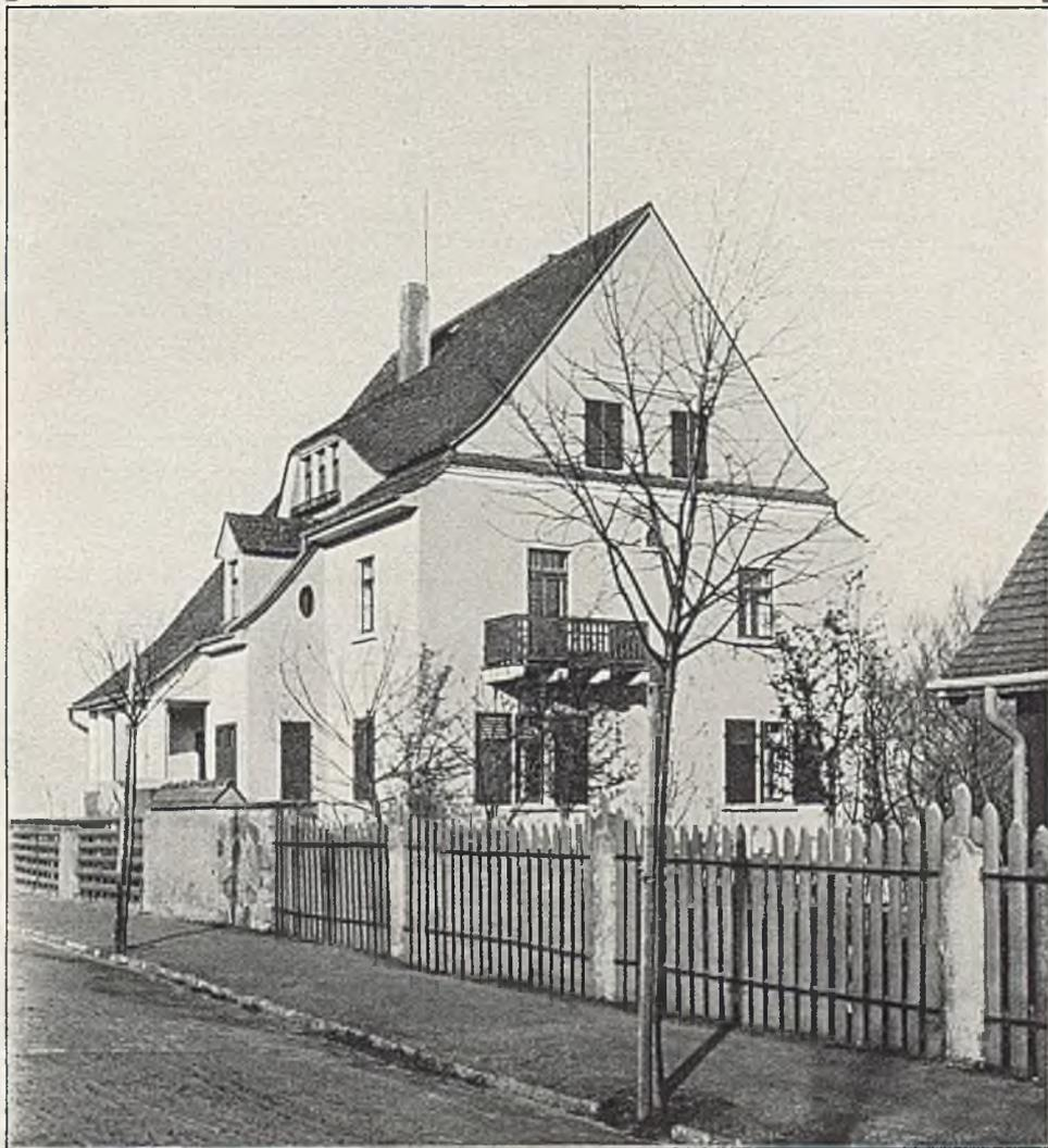
mit den schlichten Massivgiebeln, die glatten Wände, die schlichten Fenster, das Überdecken des Vorbaues auf die einfachste Art mittels Schleppdach ist von alters her landesüblich. Die Wände sind hellocker gestrichen, die geputzten Simse weiß.
