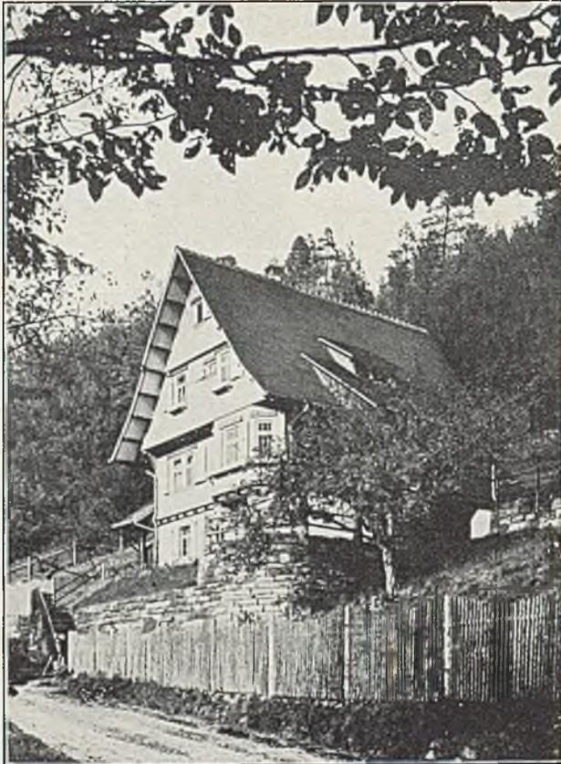
An einem für Errichtung von Bauten verhältnismäßig steilem Bergabhänge steigt der vorgezogene Giebel breit und sicher auf. Das Haus liegt über einer naturwüchsigen Trockenmauer hinter naturgrauem Fichtenstängelzaun. Der Sockel ist
