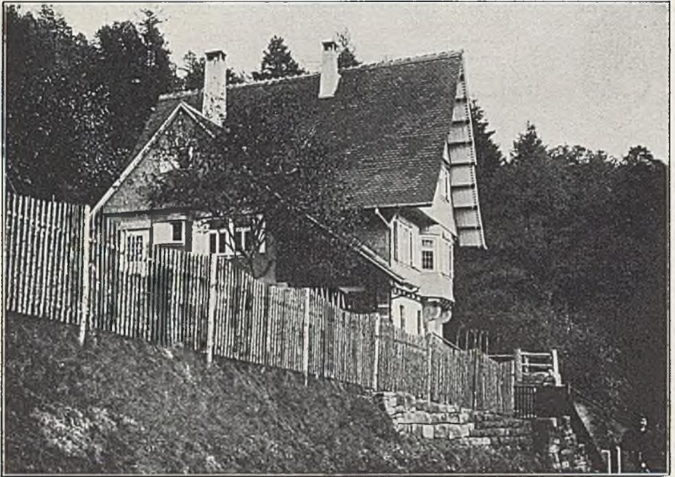
von Buntsandstein, die Hauswände sind mit Holzschindeln bekleidet, welche mit Steinöl bestrichen wurden. Die Vorsprünge, die Fenster und Türen sind weiß, letztere auch naturfarbig. Das Dach ist mit Ziegeln gedeckt. Die Hauptseite des Hauses
