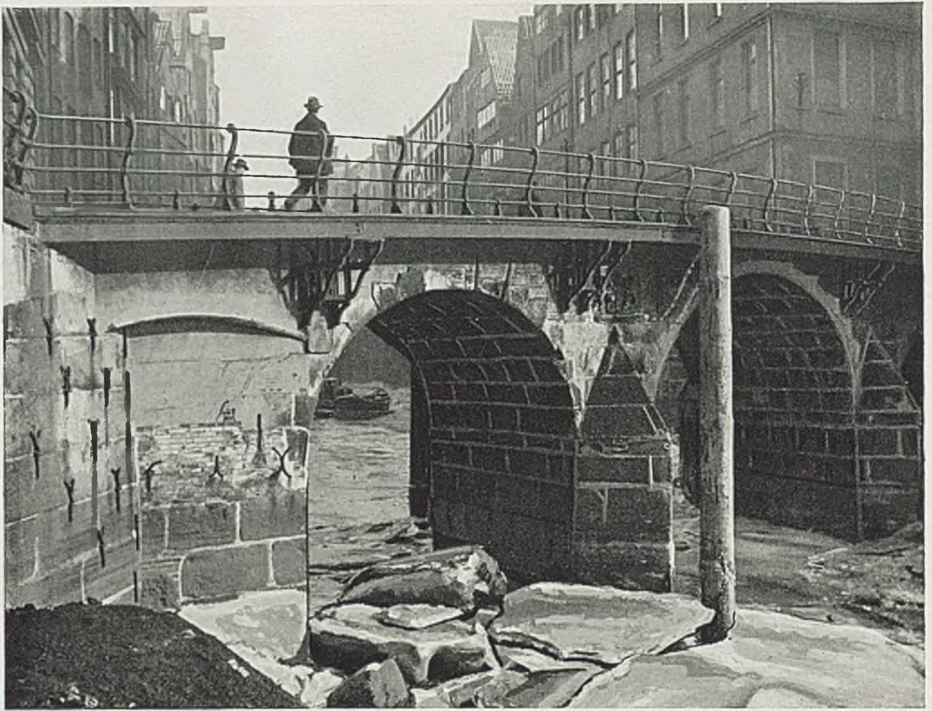
Malerisch spannt sich die alte, aus Quadern gefügte Zollenbrücke . . .
