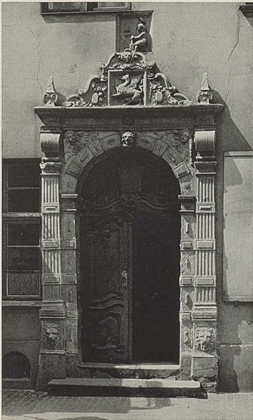
53. PORTAL DER EHEMALIGEN MÜNZE, ZIEGENMARKT 3 1620, Tür um 1760
