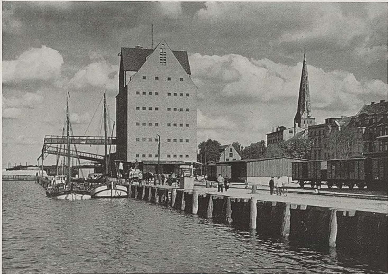
6. HAFENGELÄNDE AN DER ALTSTADT Der neue Speicherbau 1935 errichtet
