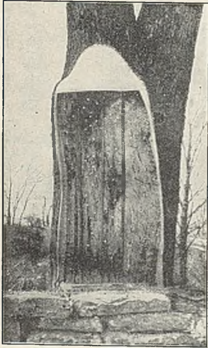
Abb. 188. Bewehrung des Hohlraumes vor der Zubetonierung.
