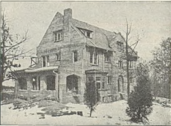
Abb. 103. Haus eines Gutes in Visconsin.
