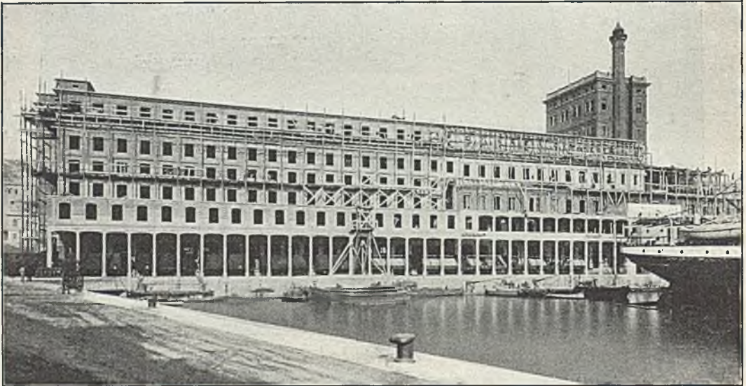
Abb. 178. Gesamtansicht. Getreidesilo Genua.
