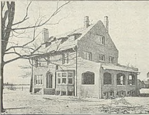
Abb. 102. Wohnhaus eines Gutes in Visconsin.
