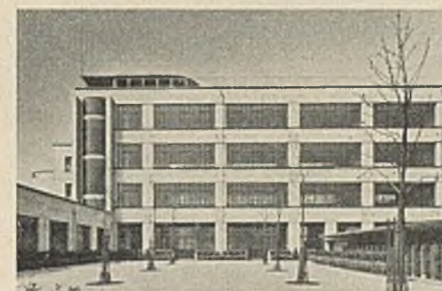
Expert, Schulanlage, Kuß-Strasse
