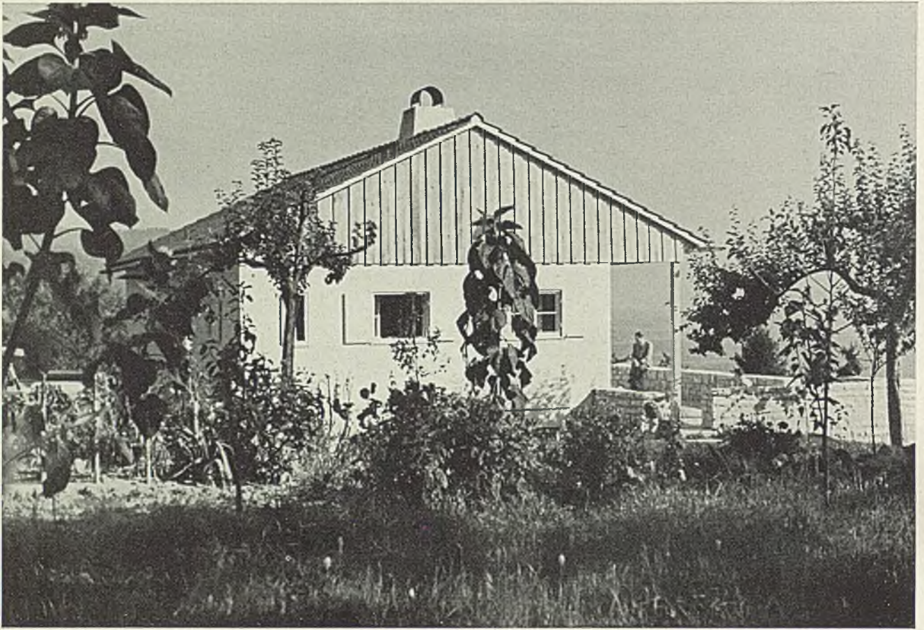
Das sorgfältige Auswiegen der Flächen und Öffnungen, der Neigungen und Profile machen den Reiz eines solchen kleinen Bauwerks in der Landschaft aus. Wir geben deshalb auf den Seiten 262/263 alle Ansichten in großem Maßstab
