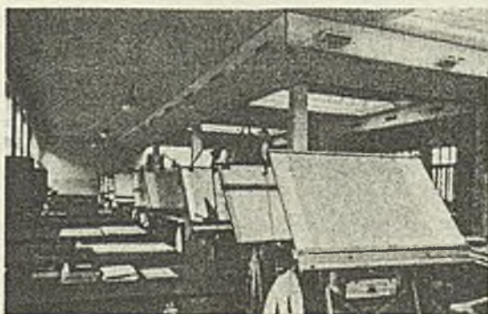
Abb. 121. Zuluft einblasung in einem Zeichensaal.
