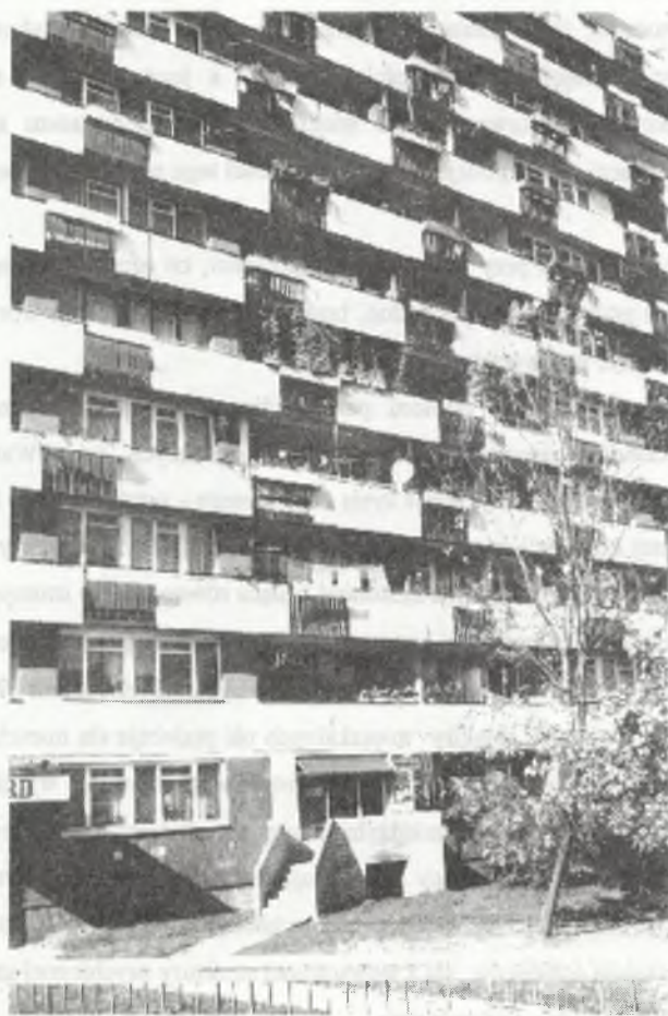
Rys. 2. Powtarzający się monotony typ artykulacji elewacyjnej budynków mieszkalnych (fot. autor) Fig. 2. An interative, monotonous type of a facade articulation of dewelling-houses
