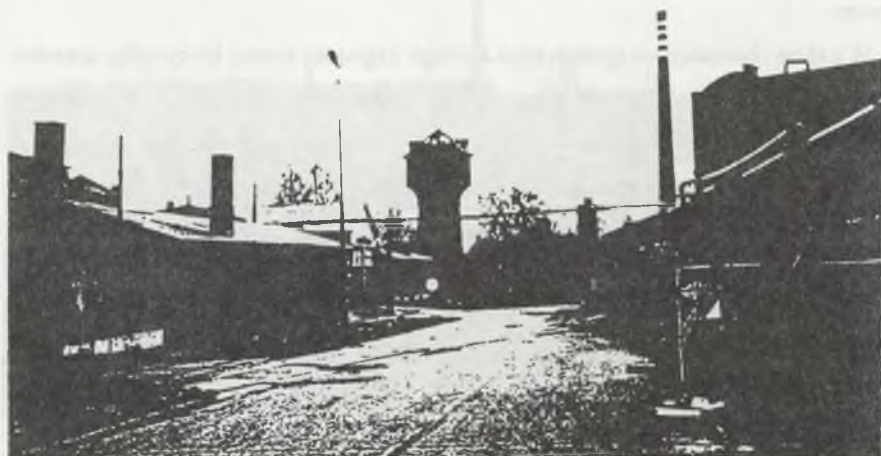
Fot.37. Zabrze - wicza ciśnieni na terenie huty od strony ul. Hagera
