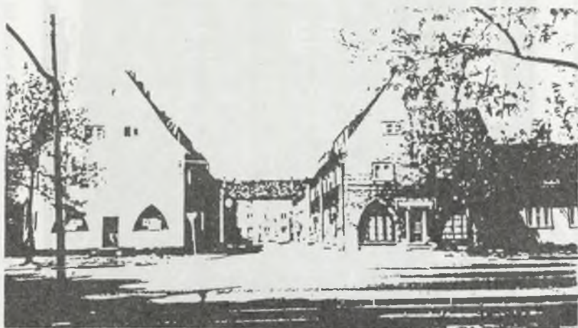
Fot.13. Zabrze, ulica Wolności. Zdecydowanie pozytywnie odbierane jest skrócenie ulicy i zamknięcie perspektywy, kąt dachu 45^\circ charakterystyczny dla regionu oraz pokrycie dachówką. Natomiast niekorzystne wrażenia sprawiają: surowe ściany szczytowe, brak zieleni i zbyt mała szerokość ulicy utrudniająca wprowadzenie zieleni
