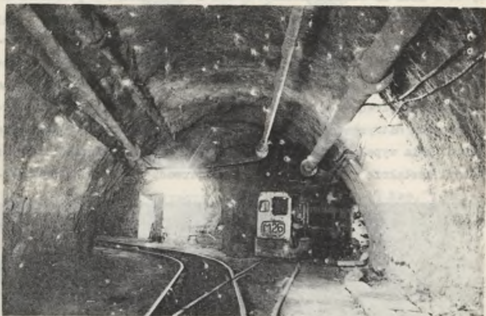
Rys. 4. Widok fragmentu skrzyżowania wykonanego w obudowie kombinowanej stalowo-betonowej z zastosowaniem betonu natryskowego
