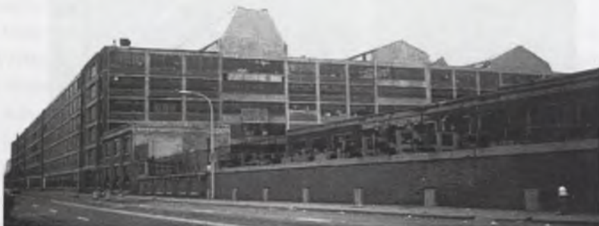
Rys. 3. Fabryka Forda, Highland Park, Stany Zjednoczone, A. Kahn, 1914, źródło: www.architectureweek.com
