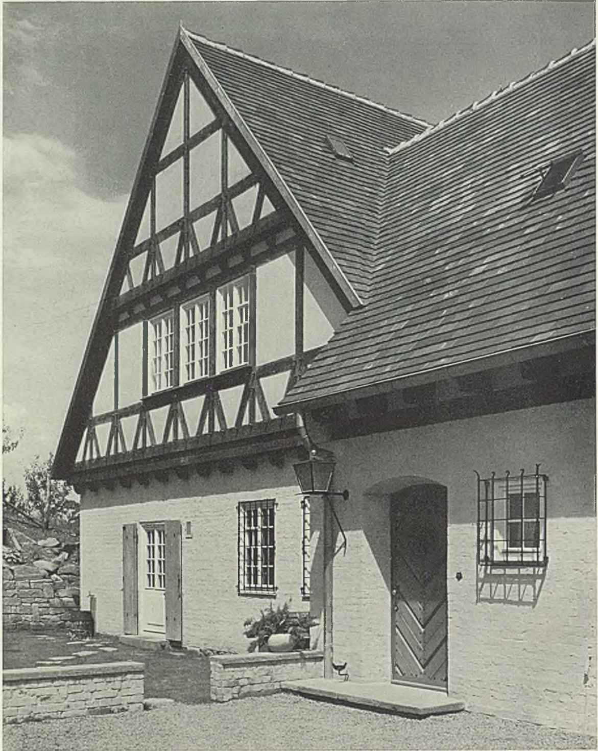
Die Eingangsseite des Hauses K. Das dunkle Tannenfachwerk ist felderweise verputzt; das Erdgeschoß in Anlehnung an das Nachbarhaus Backstein geschlämmt
