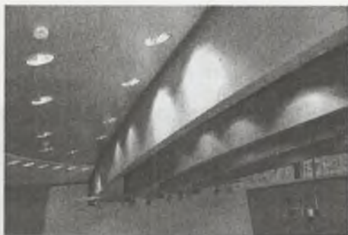
Fot. 19. Wydział Teologiczny, fragment konstrukcji stropu audytorium (Fot. B. Komar)
