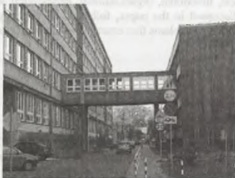
Rys. 2. Elewacja tylna budynku Politechniki, ul. Konarskiego, Gliwice (fot. autor)
