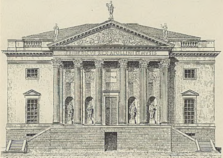
Abb. 414 Fassade des Opernhauses zu Berlin
