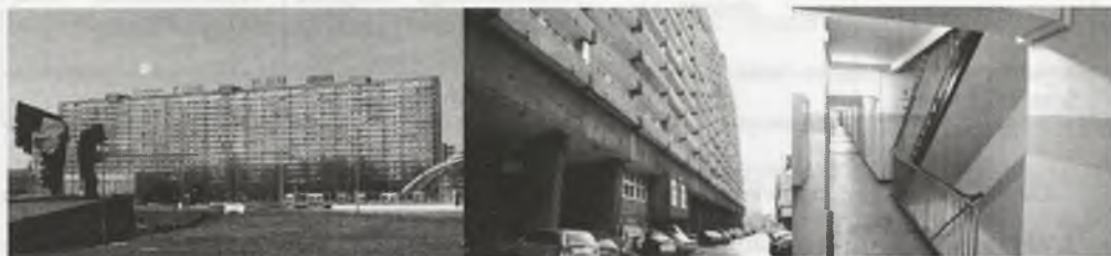
Fig. 3. Katowice, osiedle Katowickiej Spółdzielni Mieszkaniowej – Superjednostka. Fot. autor Fig. 3. Katowice Housing Cooperative estate – SuperUnit. Photo. author
