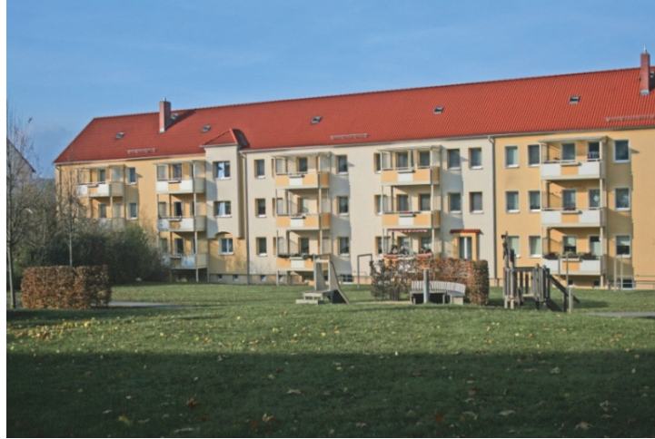
Rys. 48. Dobudowa przestronnych balkonów w Sangerhausen Fig. 48. Spacious balconies being built on to the buildings in Sangerhausen Źródło: fot. autorka.
