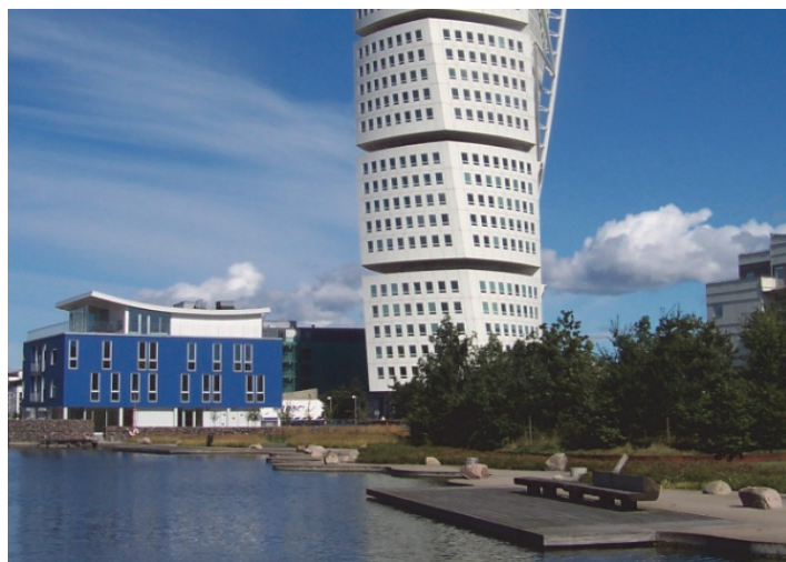
Rys. 29. Budynek mieszkaniowy Turing Torso dla osób młodszych i starszych w zabudowie mieszkaniowej Bo01 w Malmö
