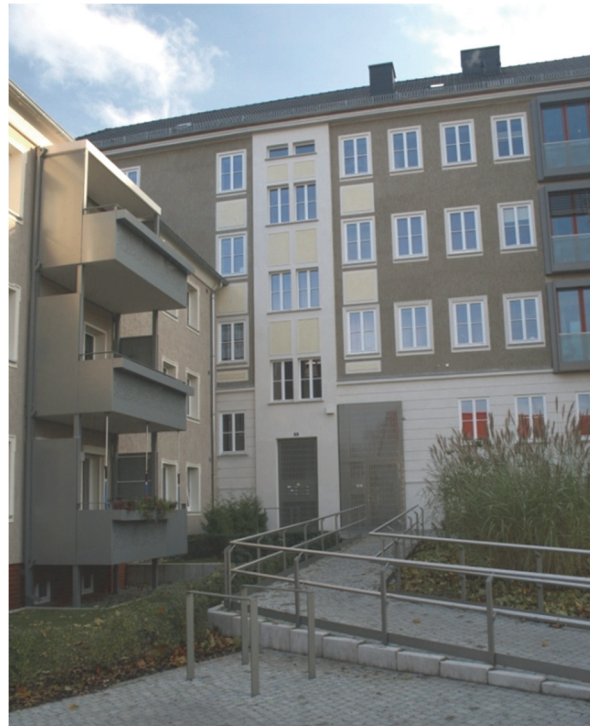
Rys. 49. Pochylnie przy wejściach do budynków na osiedlu Am Bergamnn w Sangerhausen Fig. 49. Ramps next to building entrances in Am Bergmann housing estate, in Sangerhausen Źródło: fot. autorka.
