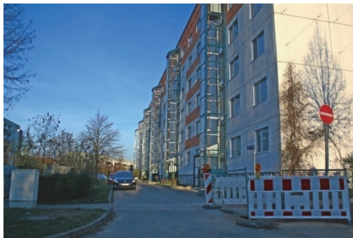
Rys. 47. Dobudowane windy do budynków mieszkalnych w Sangerhausen
