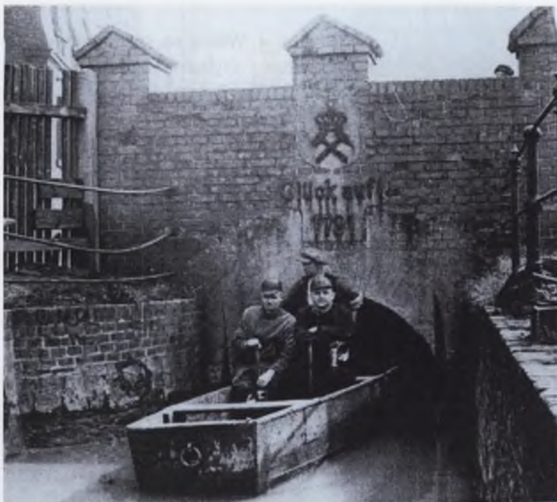
Fot. 7. Archiwum MCDB –DPT, wylot z Głównej Kluczowej Sztolni Dziedzicznej przy ul. Sztolniowej (obecnie ul. Karola Miarki)
