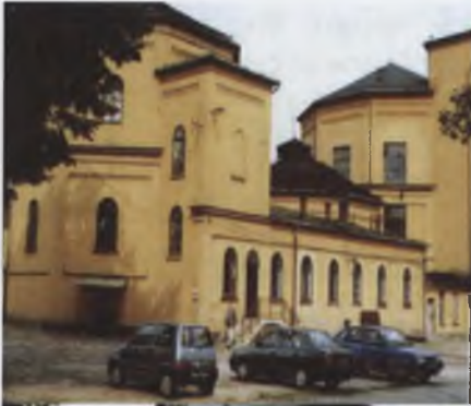
Rys. 11. Bielsko-Biała. Przykłady obiektów przemysłowych zaadoptowanych na inne funkcje: gazownia przeznaczona na biura, fabryka wyrobów filcowych przeznaczona na dyskotekę [fot. autora]
