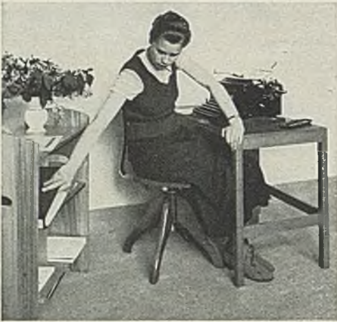
Der Fuß des Schreibmaschinentisches verhindert das Herausdrehen der Arbeitenden
