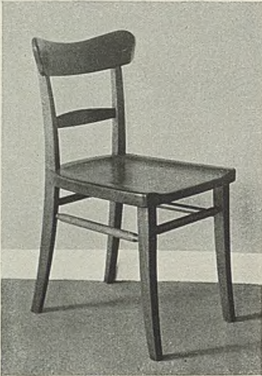
Modell 111. Brettstuhl. Die FüÙe gehen bis zur Lehne durch und sind nicht gebogen, sondern aus dem vollen Holze ausgearbeitet
