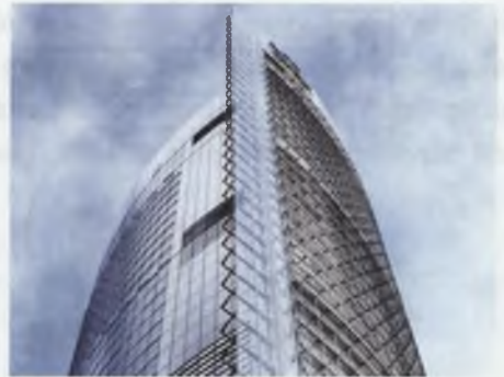
Rys. 8. Deutsche Post – odmienne ukształtowanie podwójnej fasady zależnie od stron świata
