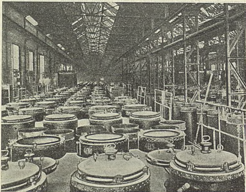
Rys. III-42. Widok ogólny piecowni do azotowania karbidu metodą Franka i Caro
