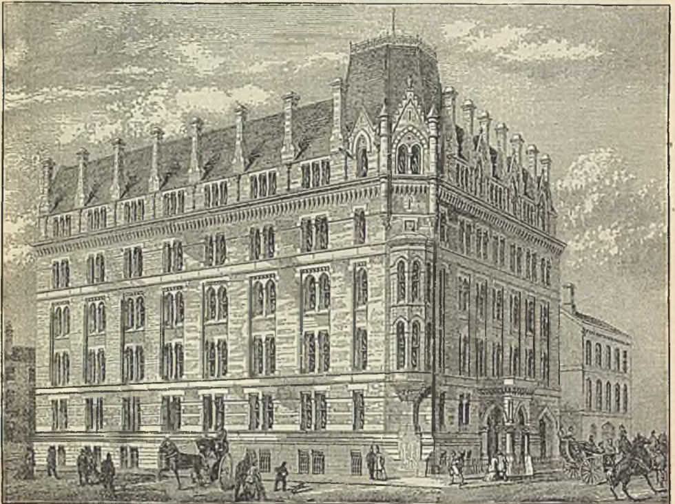
230. Товарный складъ въ Манчестерѣ, построень Т. Ворthingтономъ. По „The Builder“.
