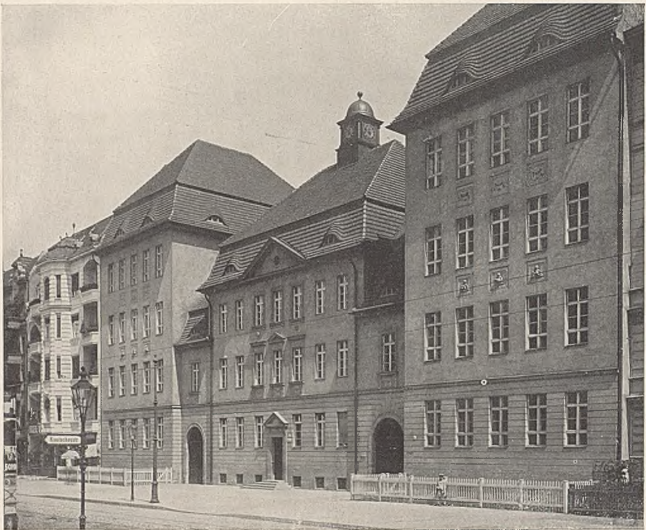
GEMEINDESCHULE AN DER TEGELER STRASSE.
