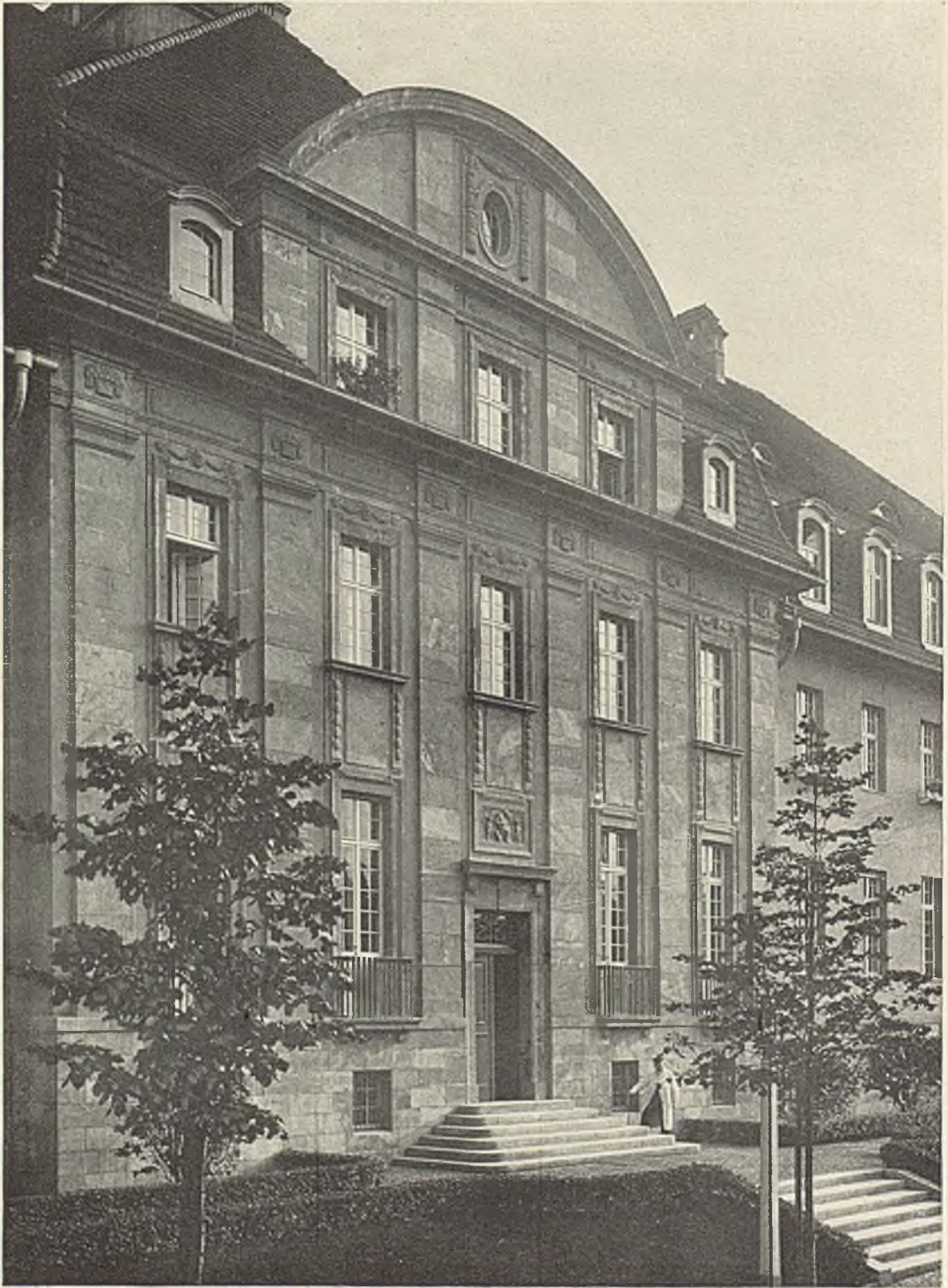
ALTE LEUTE-HEIM IN BUCH. VERWALTUNGSGEBÄUDE. VORDERE PASSADE, MITTLERER THEIL.
