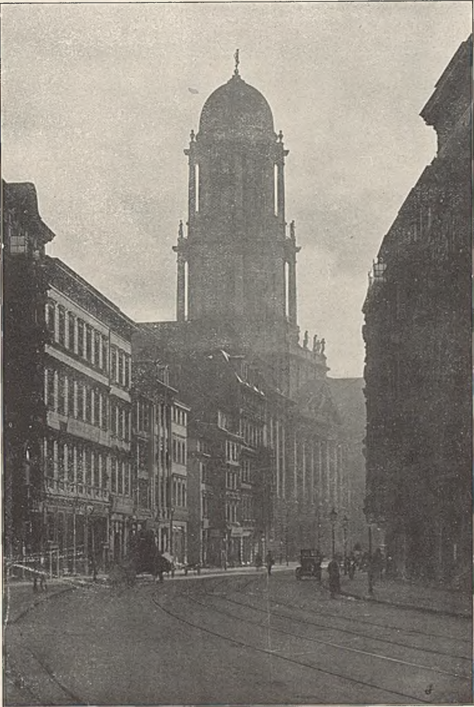
NEUES STADTHAUS. BLICK AUS DER JÜDENSTRASSE.
