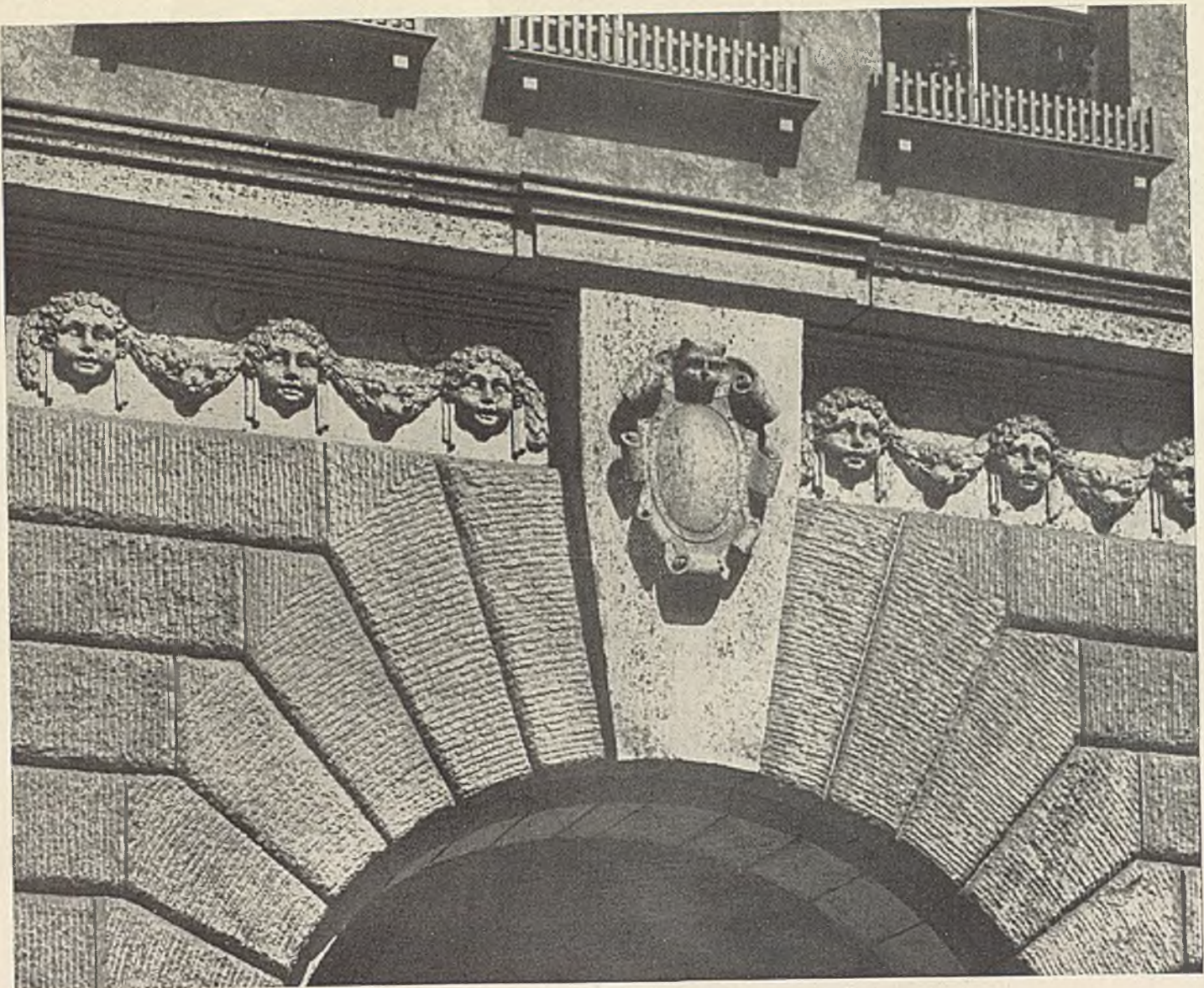
GEMEINDE-DOPPELSCHULE AN DER BÖTZOWSTRASSE. FASSADE, DETAIL.
