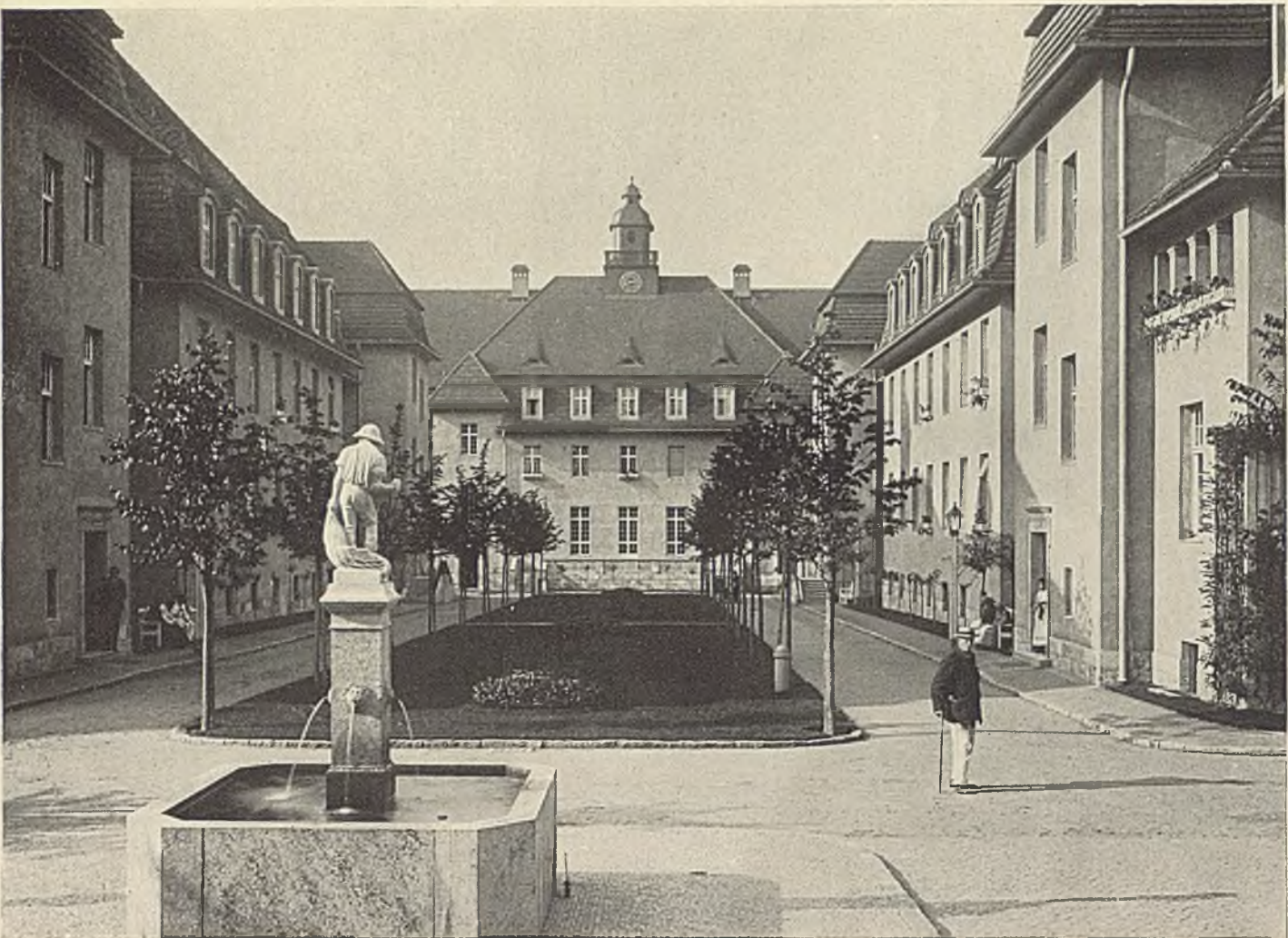
ALTE LEUTE-HEIM IN BUCH. BLICK VOM KÖCHENGEBÄUDE NACH DEM VERWALTUNGSGEBÄUDE
