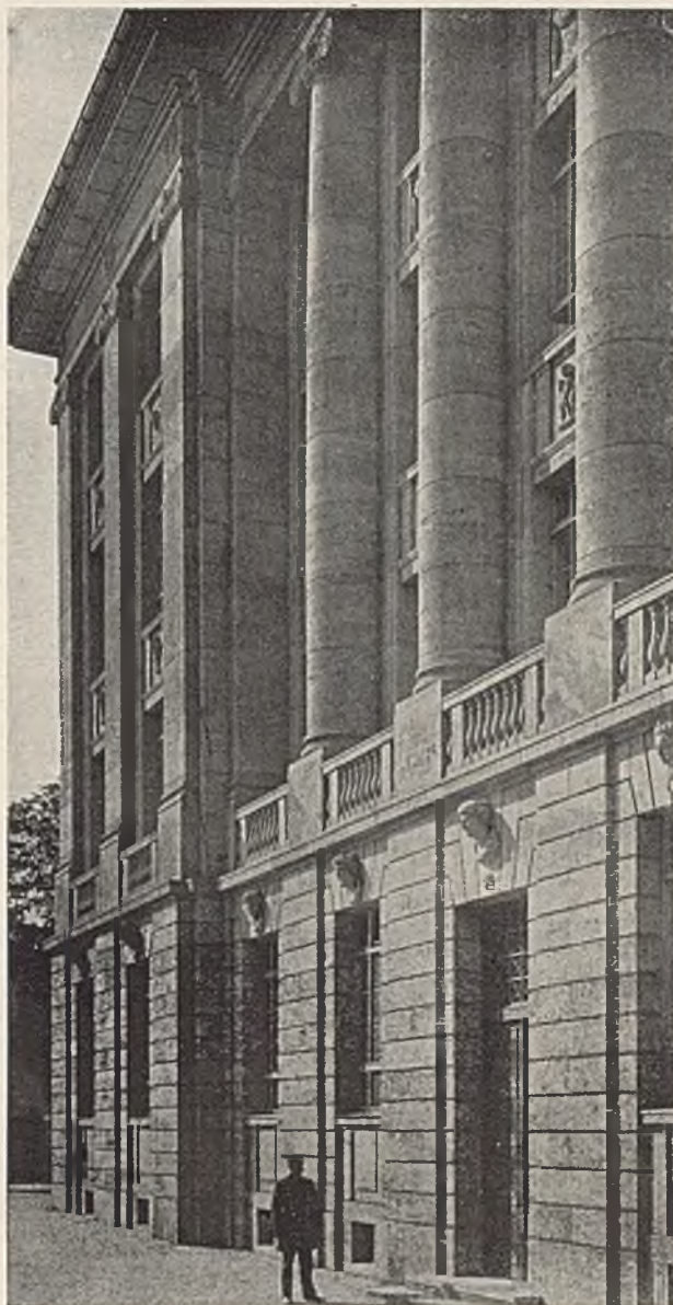
Abb. 13. VERWALTUNGSGEBÄUDE DER STÄDTISCHEN GASWERKE. FASADENDETAIL.
