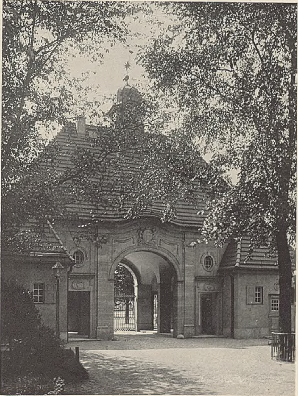
TORGEBÄUDE AM FRIEDHOF IN FRIEDRICHSFELDE. FASSADE NACH DEM FRIEDHOF.
