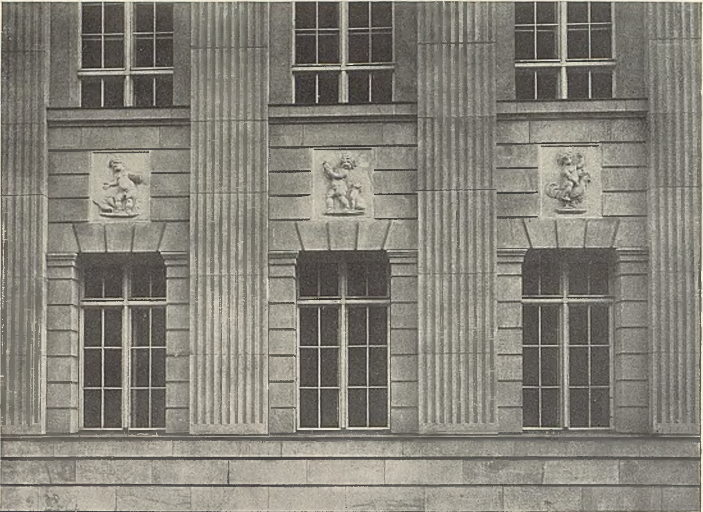
GEMEINDESCHULE AN DER ZWINGLISTRASSE. FASADE, DETAIL.
