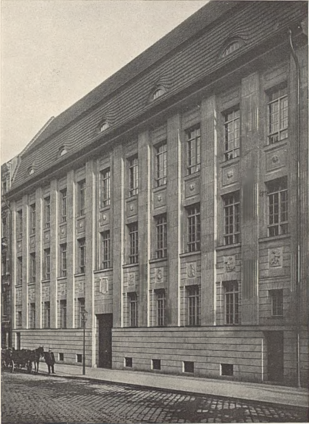
GEMEINDESCHULE AN DER ZWINGLISTRASSE.
