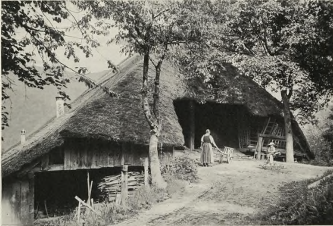
Einfahrt auf der Rückseite des Hauses
