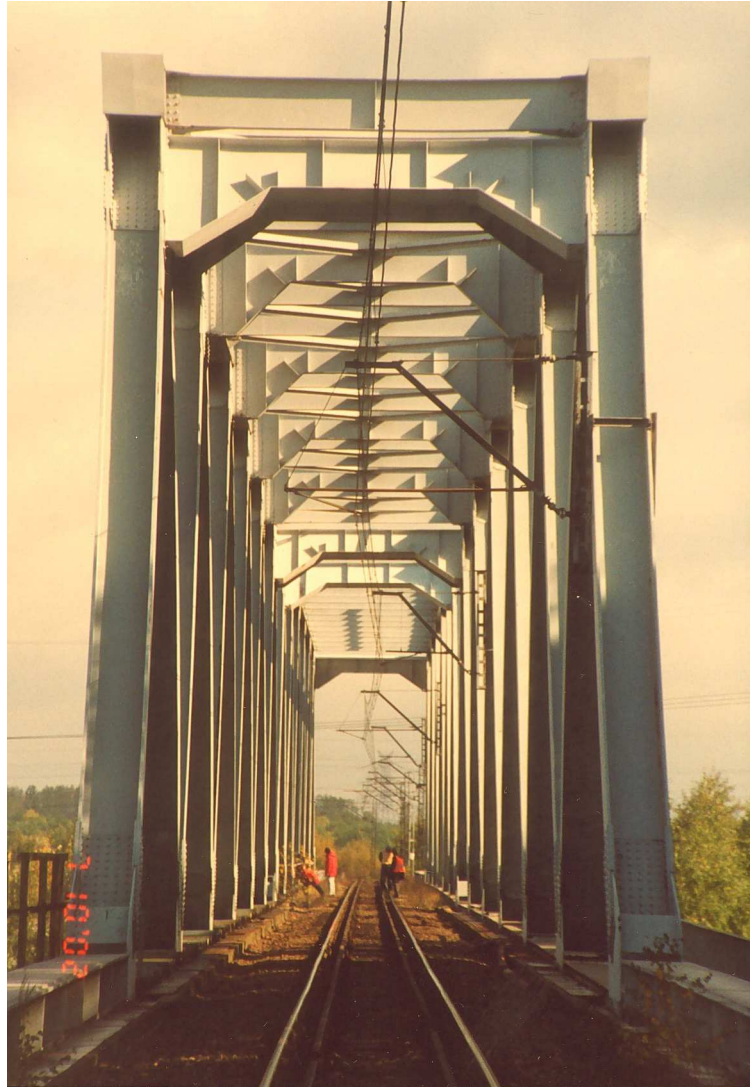
Rys. 4-1. Widok wzdłuż obiektu
