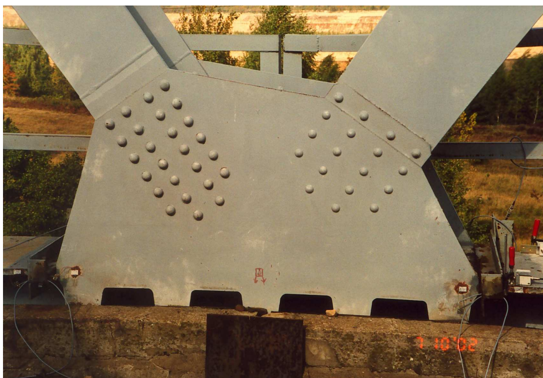
Rys. 4-5. Przęsło nieuszkodzone. Widok na węzeł przy przerwie dylatacyjnej w korycie
