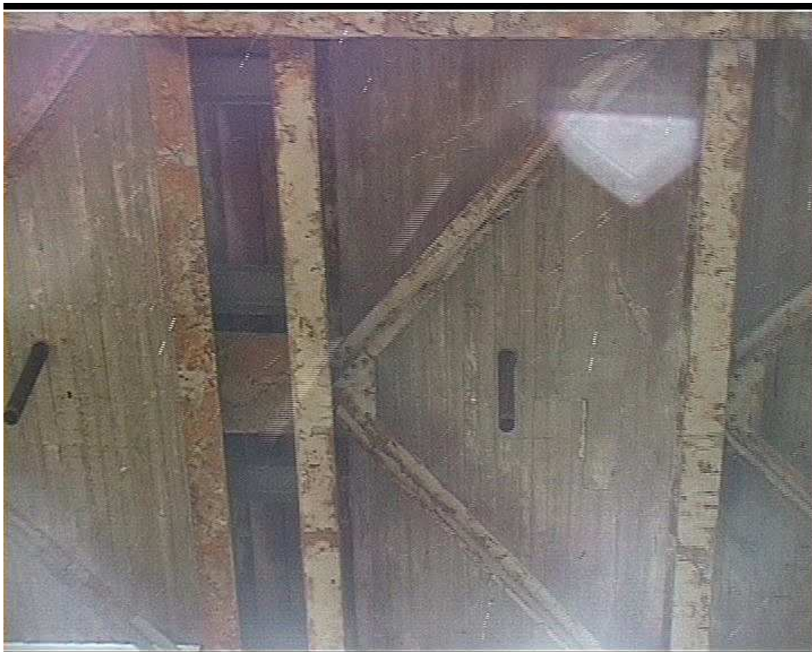
Rys. 5-10. Przęsło nieuszkodzone. Dodatkowe przewiązki ramowe
