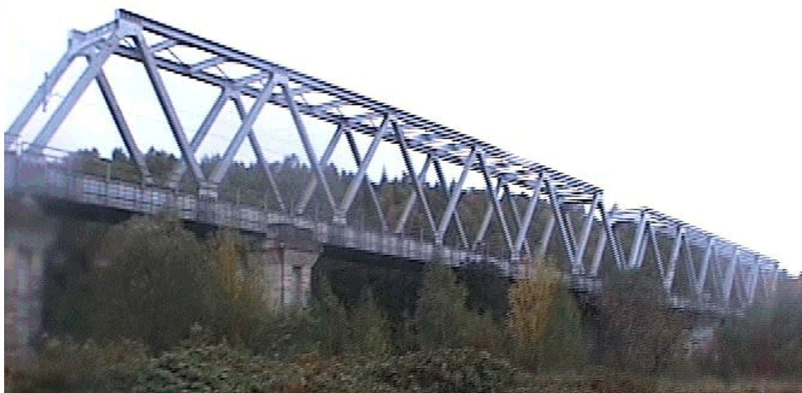
Rys. 2-2. Widok na główne przęsła środkowe
