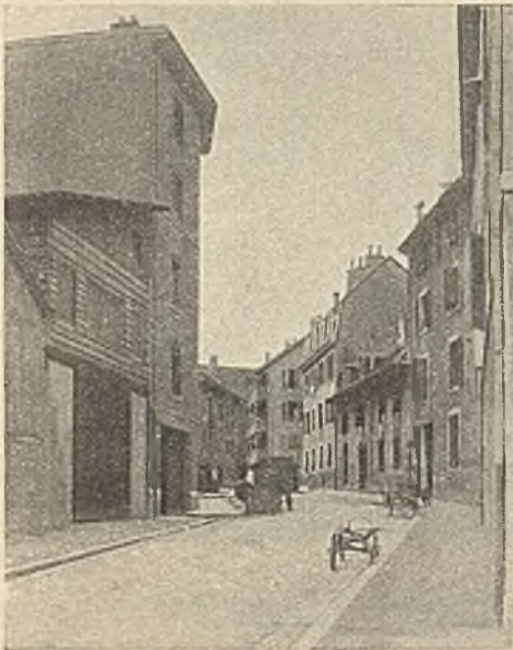
Fig. 339. L'aspect chaotique de ces constructions de différentes hauteurs et catégories est lamentable (quartier neuf à proximité d'une gare).
