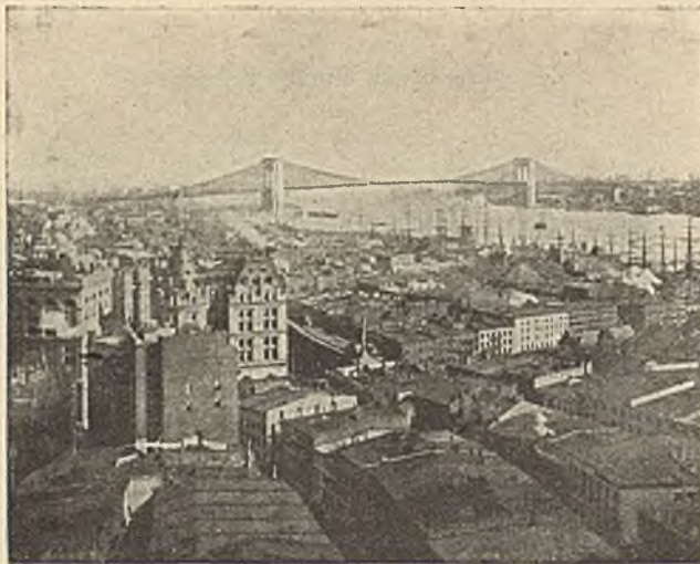
Fig. 319. L'ancien pont de Brooklyn franchissant New-York entre l'île de Manathan et la ville de Brooklyn.
