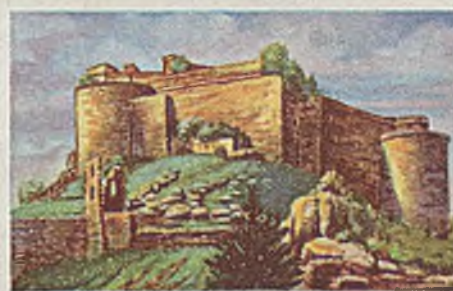
HOHEN-NEUFFEN Die Ruine, am Rande der Schwäbischen Alb gelegen, beherrscht weithin die Gegend. Dem mittelalterlichen Burgkern wurden im 16. Jahrh. mächtige Geschütztürme vorgelegt. In der kolossalen Geschlossenheit der mit dem Felsunterbau verwachsenen Baumasse und ihren großen Umrissen von imponierendem Eindruck.
