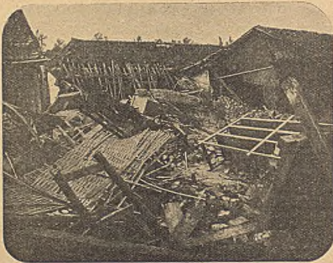
Durch Erdbeben zerstörtes Chinesenviertel in Tjandjor (Java)
