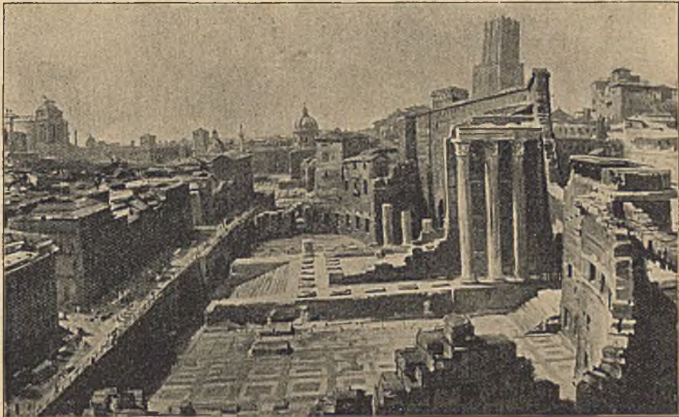
Via Alessandrina Trajansforum der östliche halbkreisförmige Abschluß Das Priorat der Ritter von Rhodos Das Augusta-Forum Die Torre delle Milizie, davor der Tempel des Mars Ultor
