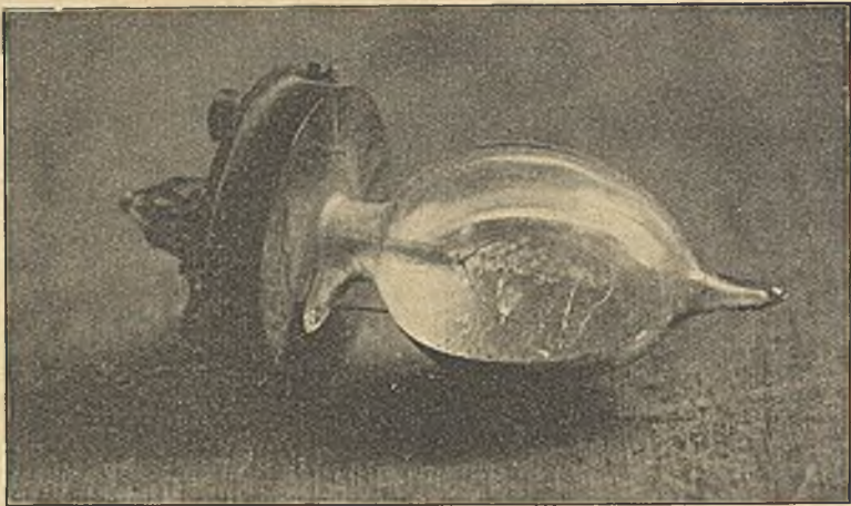
Die Photozelle, das künstliche Auge, die die photographierten Schallwellen in elektrische Ströme verwandelt
