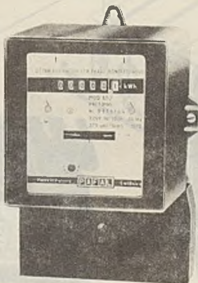
Licznik w osłonie bakelitowej
