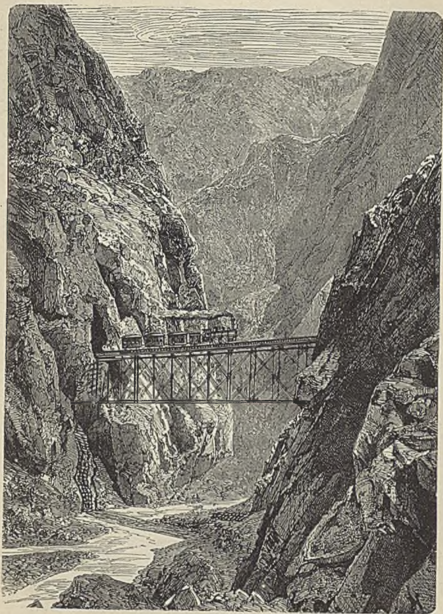
39. Viadukt zwischen Lima und Droha in Peru.
