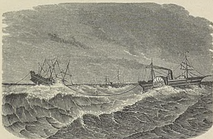
123. Auslegung eines unterseeischen Kabels.
