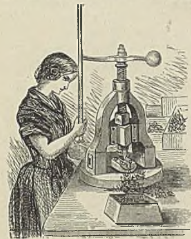
146. Das Anbiegen der Stahlfedern.
