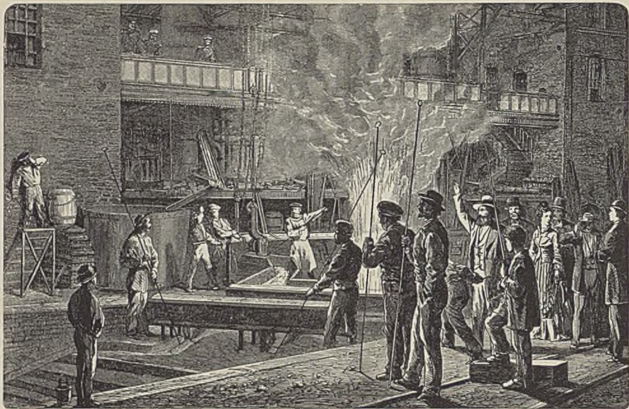
66. Gießhalle einer Eisengießerei.
