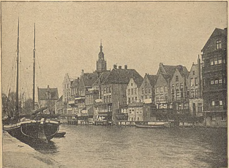
Der alte innere Emdener Hafen (Rathausdelft) Photographie von Fritz Fischer, Emden
