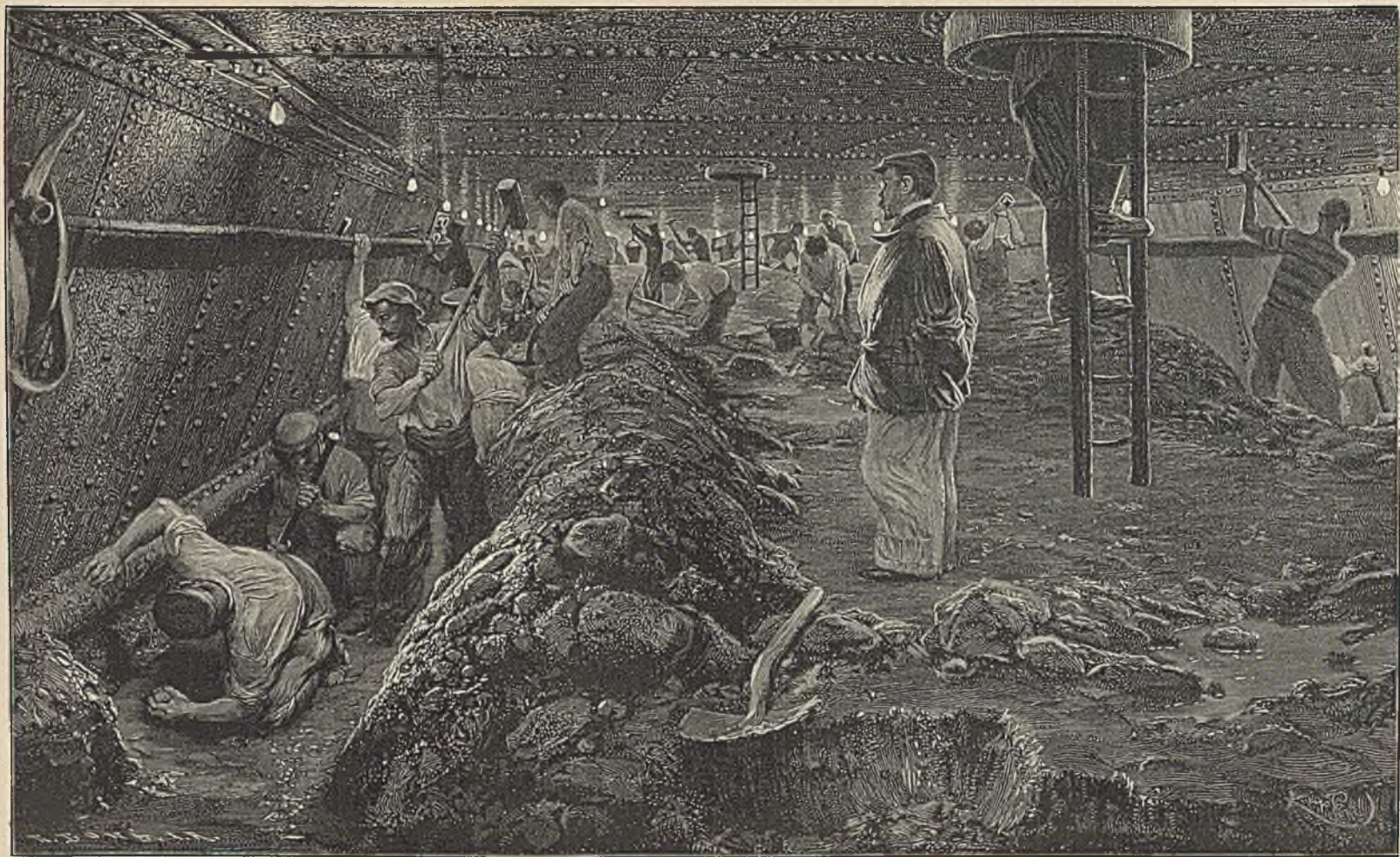
Tunnelbau unter dem Seineflusse für die Pariser Untergrundbahn Nach einer Zeichnung von Kupka
