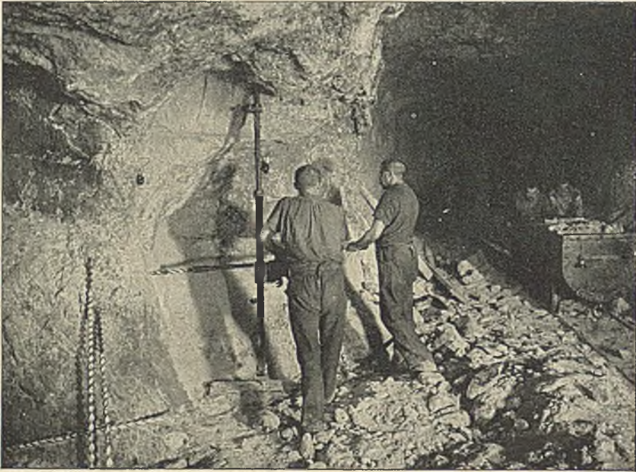
Abbau von Carnallit-Salzen auf der 300-Meter-Sohle eines Kali-Bergwerkes
