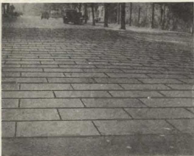
Rys. 6. Widok wykonanej nawierzchni ul. Rybnickiej - wzdłuż osi jezdni
