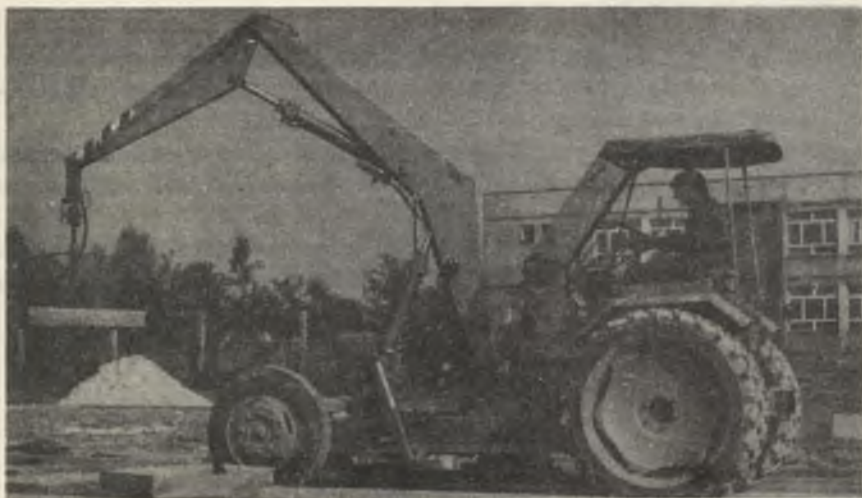
Rys. 5. Sposób układania płyt z betonu prasowanego - widok ogólny
