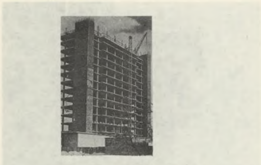
Rys. 3. Szkielet słupowo-płytowy bezryglowy budynku biura projektów w Leningradzie, zmontowany leningradzkim systemem podnoszenia przekryć - fot. reprodukcja z miesięcznika Stroitelstvo i Architektura Leningrada
