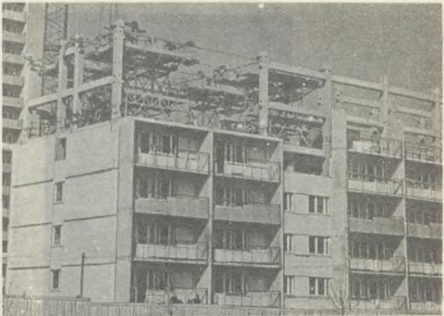
Rys. 14. Konstrukcja szkieletowo-wielkopłytowa budynku mieszkalnego serii II-04, realizacja w Moskwie - fot. L. Rowiński
