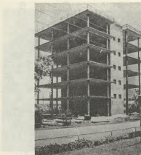
Rys. 7. Szkielet słupowo-płytowy bezryglowy budynku mieszkalnego zmontowany NRD-owskim systemem metody podnoszenia przekryć - fot. reprodukcja z książki: O. Büttner "Hubverfahren im Hochbau"
