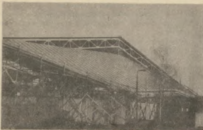
Rys. 14. Fragment dachu z płytami dwupowłokowymi na niższej części hali
