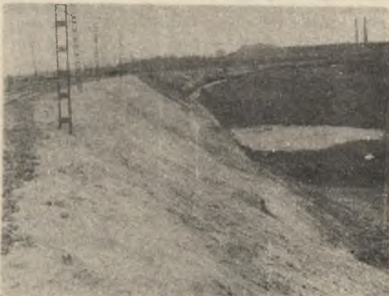
Rys. 4a. Niecka u podstawy nasypu wypełniona wodą (zdjęcie)
