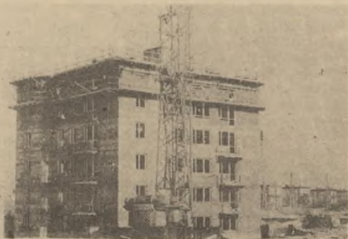
Fot. 3. Równoległe wznoszenie ścian i stropów budynku realizowanego w systemie "Ślizg-ROW"
