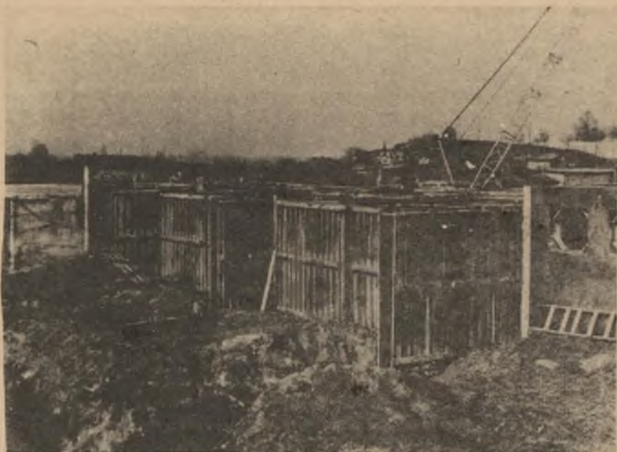
Fot. 6. Formowanie ścian parteru domów jednorodzinnych w stalowych formach wielkowymiarowych systemu GZ
