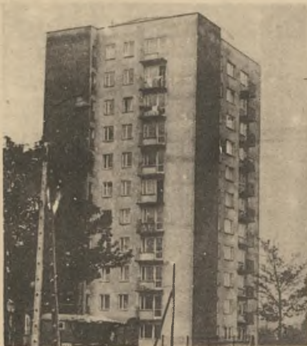
Fot. 1. Budynek typu S-13 zrealizowany w systemie "Ślizg-ROW"
