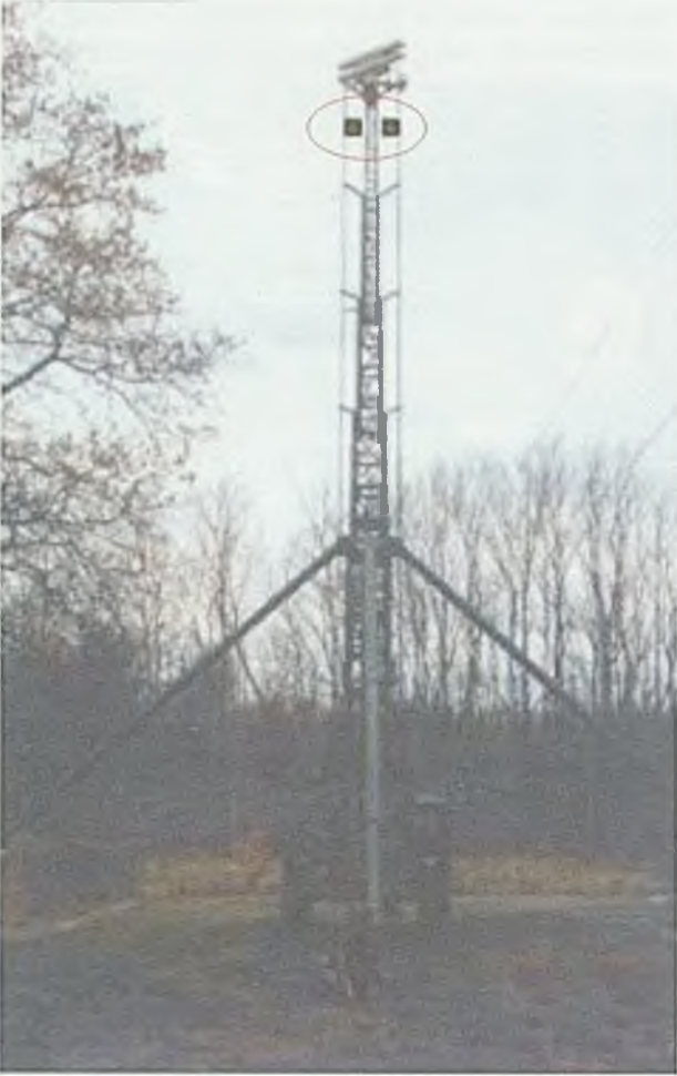
Rys. 6.10. Dwukopułowa wersja urządzenia LEMUR-10 zainstalowana na maszcie cichego radaru FMCW
