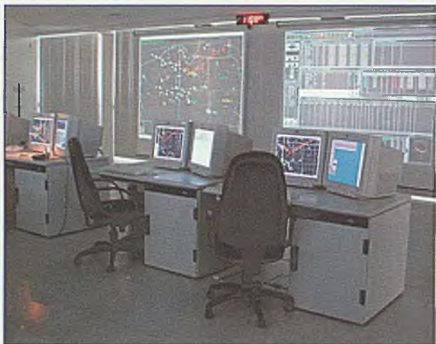
Rys. 10.7. Centrum dowodzenia sektorem OP CDS (prototyp). Widok na zautomatyzowane stanowiska pracy (dwuekranowe). Na drugim planie widoczne zobrazowanie wielkoformatowe (dwa ekany)
