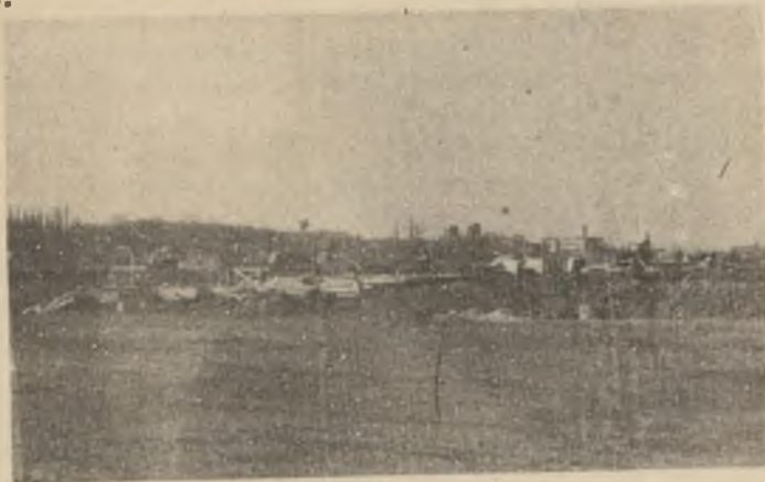
Rys. 2. Ogólny widok nasypu budowlanego
