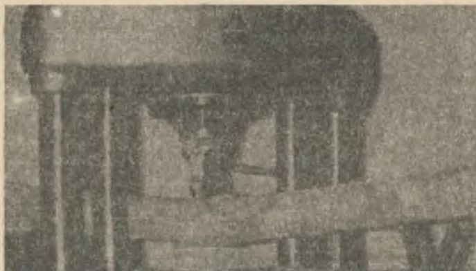
Rys. 5. Badanie okładzin w prasie wytrzymałościowej
