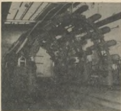
Rys. 7. Chodnikowo-komorowa obudowa firmy Salzgitter
