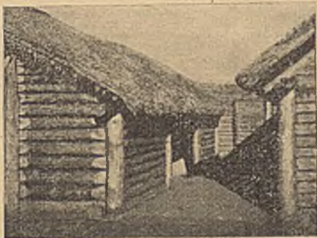
Ulica poprzeczna w Biskupinie. Budowa ścian domów łątkowo-sumikowa (rekonstrukcja).
