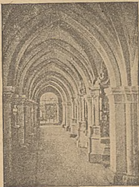
Nawa północna kościoła klasztornego OO. Cystersów w Mogile pod Krakowem. (Klasztor i kościół budowany na początku w. XIII; na rycinie widać kolumny romańskie, natomiast łuki sklepien już ostre, gotyckie).
