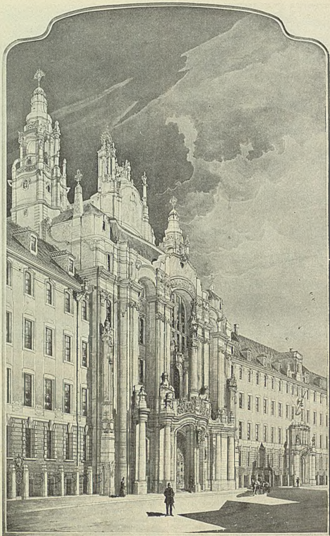
Abb. 102. Land- und Amtsgericht I in Berlin. Mittelbau an der Neuen Friedrichstraße (aus der Sammlung des Ministeriums der öffentlichen Arbeiten)
