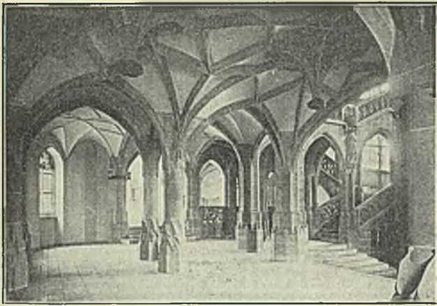
Flur im Erdgeschoß der Treppenhalle
