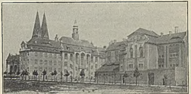
Gefängnis und Rückseite des Gerichtsgebäudes Abb. 177-179. Amtsgericht in Lichtenberg
