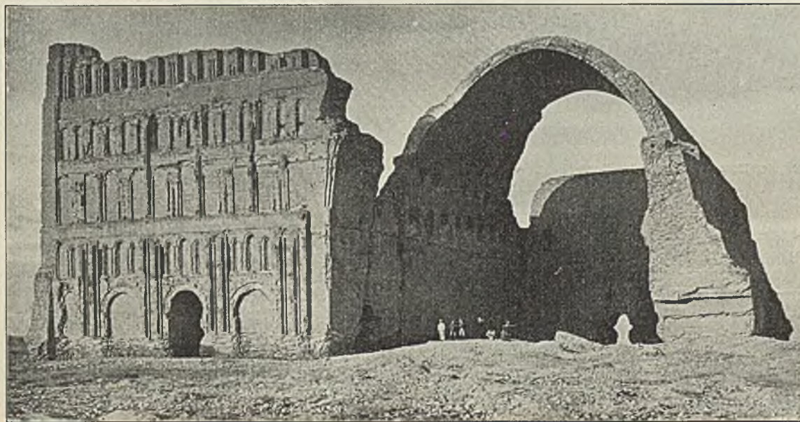
Abb. 249. Ktesiphon Thronsaal (Zustand 1907; rechter Flügel der Fassade fehlt) Spannweite des Thronsaales 24 m — Aufnahme von Georg Stephan
