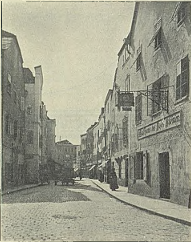
Abb. 350. Die Schmidgasse in der Innstadt mit der typischen über die Dachtraufe hinausgehenden Fassade
