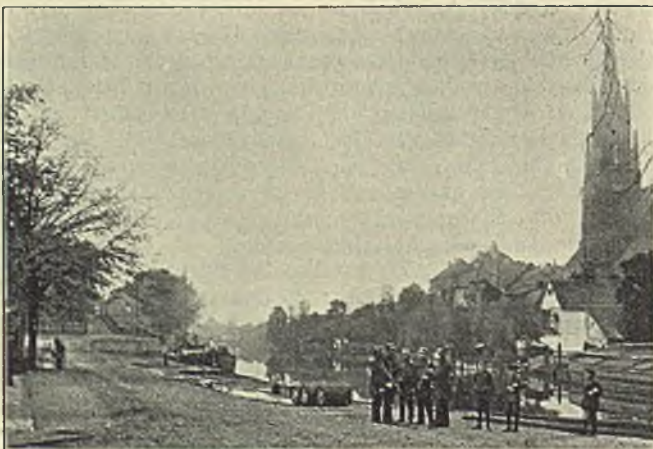
Abb. 366 (oben): Rathenower fossatum stromauf gesehen Abb. 367 (rechts): Abmündung des fossatum in Rathenow (Abb. 366 und 367 eigene Aufnahmen)
