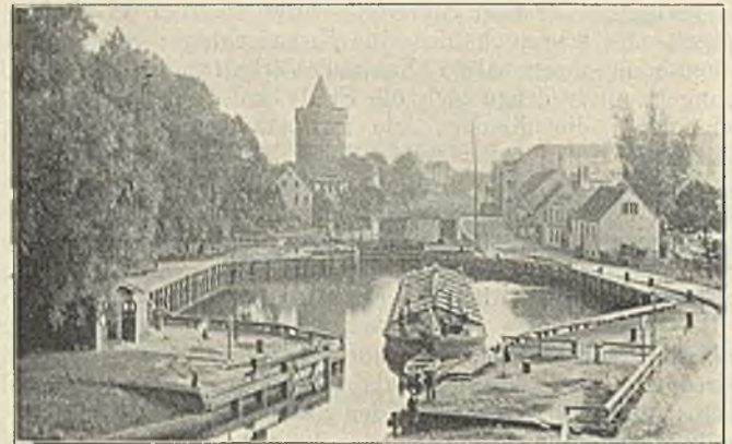
Abb. 394. Stadtschleuse Brandenburg „vor dem Steintor“ (eigene Aufnahme)
