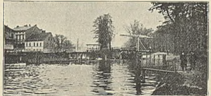
Abb. 395. Stauanlage Spandau vom Wasser aus (eigene Aufnahme)
