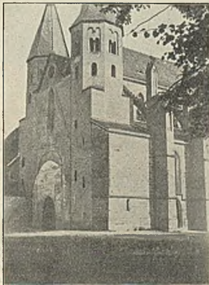
Abb. 429. Stiftskirche zu Wimpfen Südwestlicher Turm vor dem Abschlagen des Putzes
